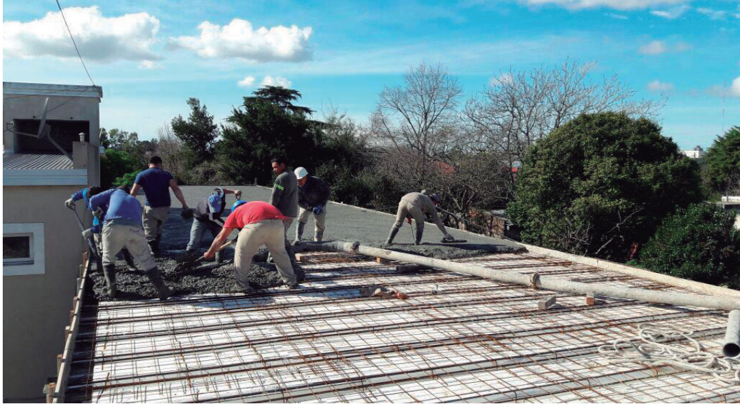
Proceso de hormigonado
