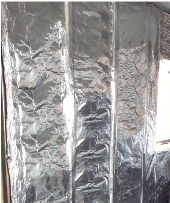
Secuencia de instalación con Lana de vidrio por el interior
