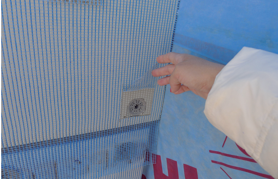
Placa termoaislante Poliéstireno Expandido revestida prefabricada para EIFS
