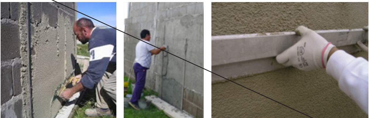
Revoque premezclado termoaislante con perlas de Poliestireno Expandido aditivadas y capacidad hidrófuga
