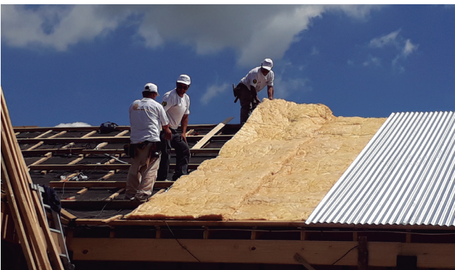
Secuencia de renovación de techo de cubierta de chapa
