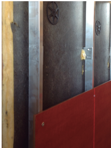
Aislamiento por el exterior con Lana de vidrio con velo negro
