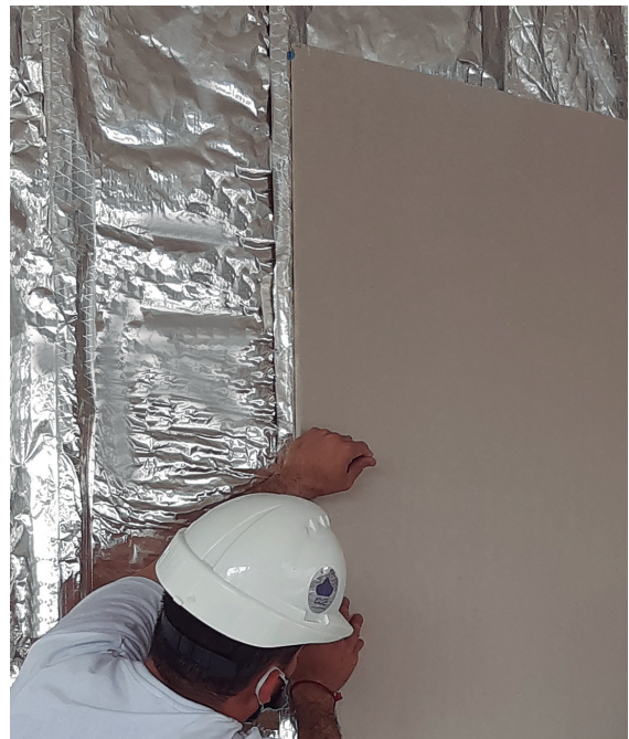
Secuencia de instalación con Lana de vidrio por el interior
