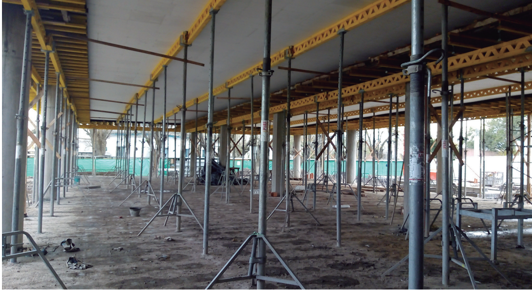
Apuntalamiento cada 1,50 m
