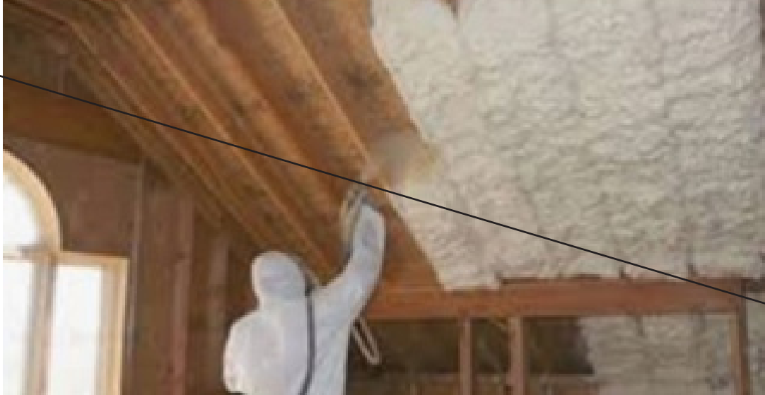
Poliuretano Proyectado para techos interior - machimbre
