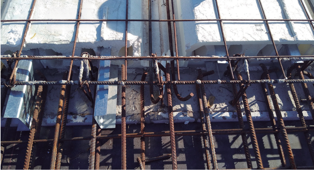
Armadura en cada nervio y armadura superior del bloque
