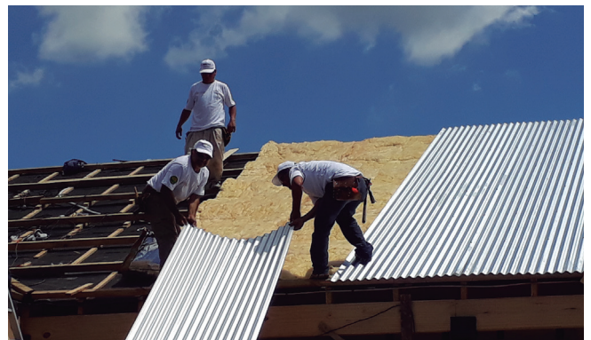
Secuencia de renovación de techo de cubierta de chapa
